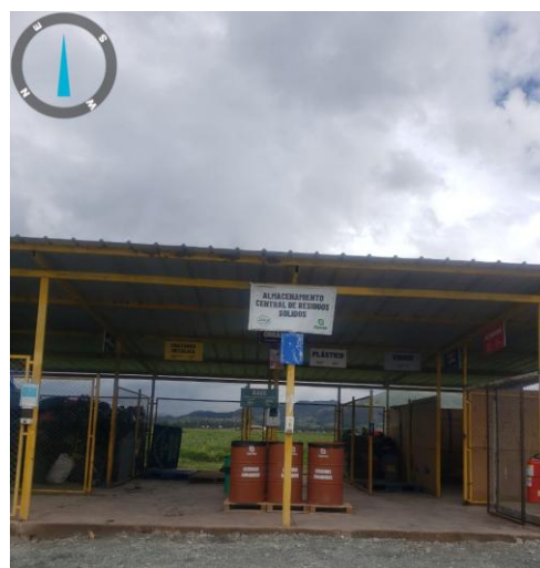
Almacén central de residuos Sólidos-Planta Cuzco
