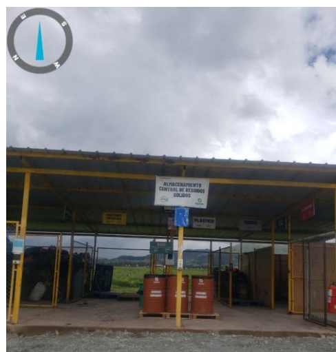
Almacén central de residuos Sólidos-Planta Cuzco
