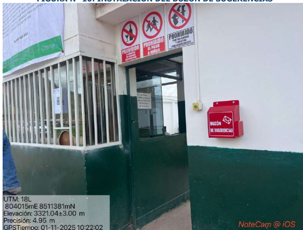
FIGURA N° 10: INSTALACIÓN DEL BUZÓN DE SUGERENCIAS
