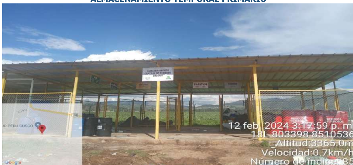
FIGURA N° 5: CONTENEDORES UTILIZADOS EN LA PLANTA INDUSTRIAL PARA EL ALMACENAMIENTO TEMPORAL PRIMARIO
